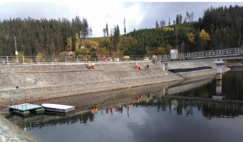
↑ Spárování dlažby návodního líce VD Horní Bečva
