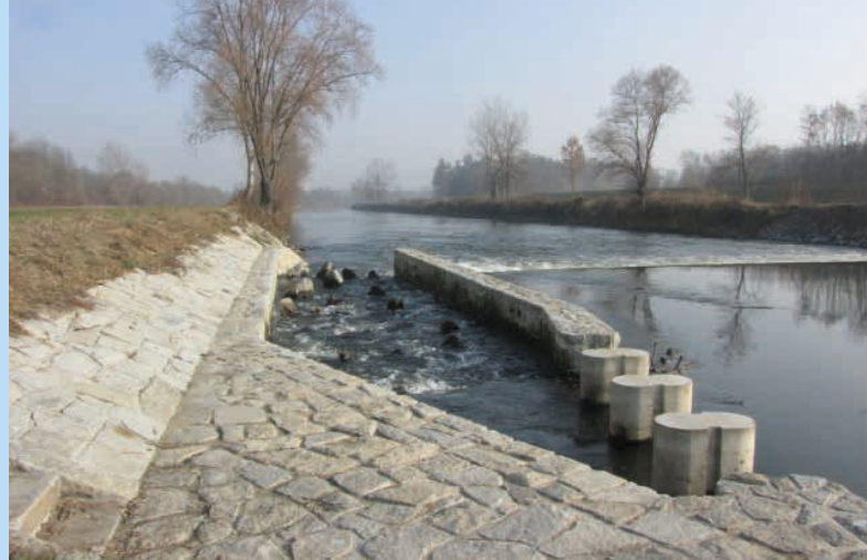
↑ Na Jamborovu práhu v Lednici je rybí přechod umístěn u levého břehu
