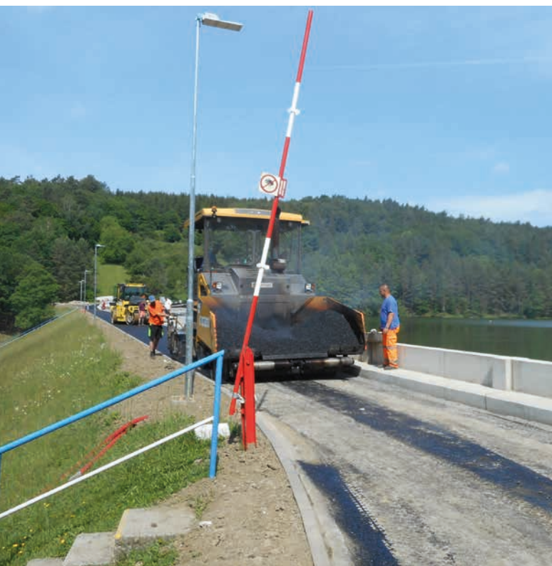
↑ Rekonstrukce komunikace VD Ludkovice
