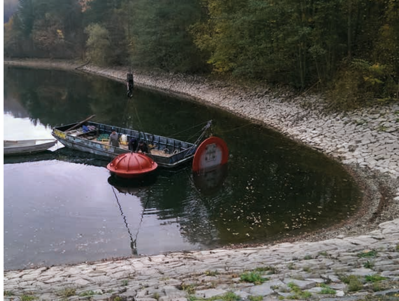
Práce na bezpečnostním přelivu VD Koryčany, červenec 2018 ↑
