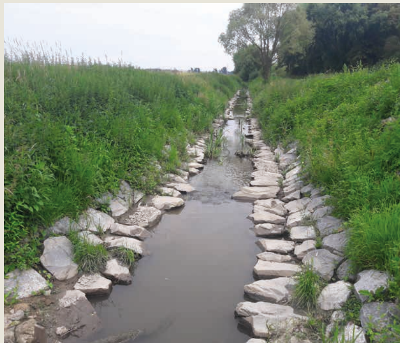
Pohled na začátek opraveného úseku řeky Rokytky ↑
