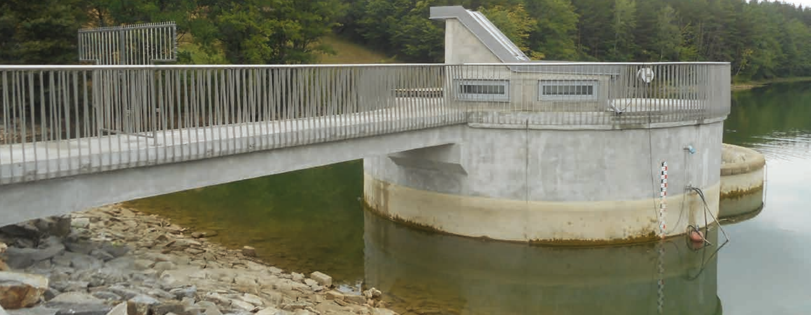
VD Ludkovice po rekonstrukci ↑
