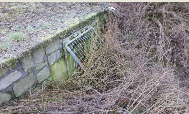
Hrazený propustek v PPO Zvole před údržbou ↑ ...a po údržbě ↓
