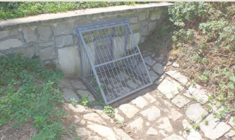
Hrazený propustek v PPO Zvole před údržbou ↑ ...a po údržbě ↓
