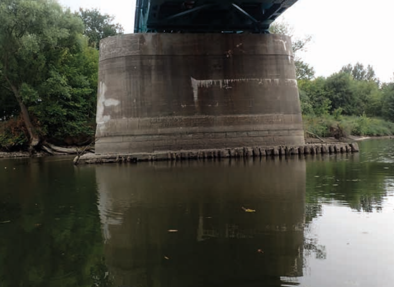
↑ Železniční most Rohatec v srpnu 2018
