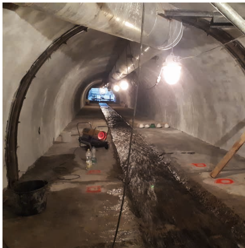
Sanace štoly VD Ludkovice ↑
