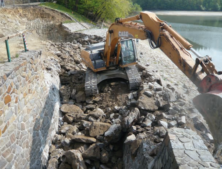
↑ Bourací práce na bezpečnostním přelivu VD Koryčany
