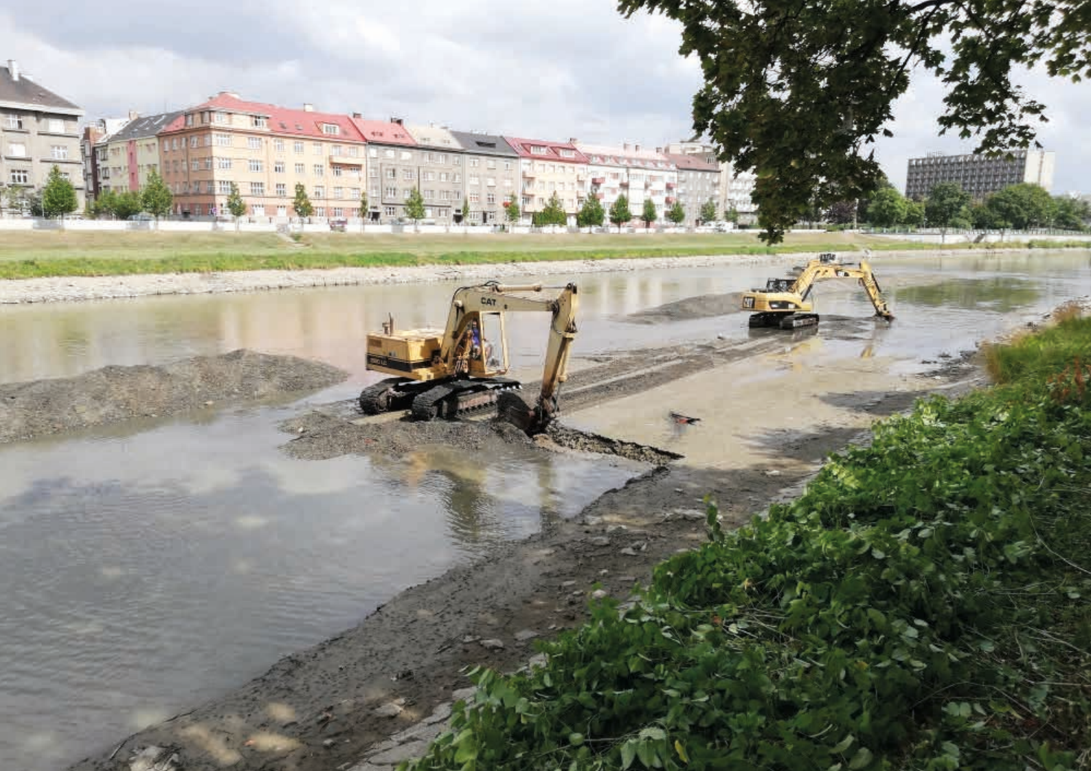
Štěrkopísek v okolí jezu v Přerově rozhrnula těžká technika ↑ Údržba jezu v Přerově při vypuštěné jezové zdrži ↓
