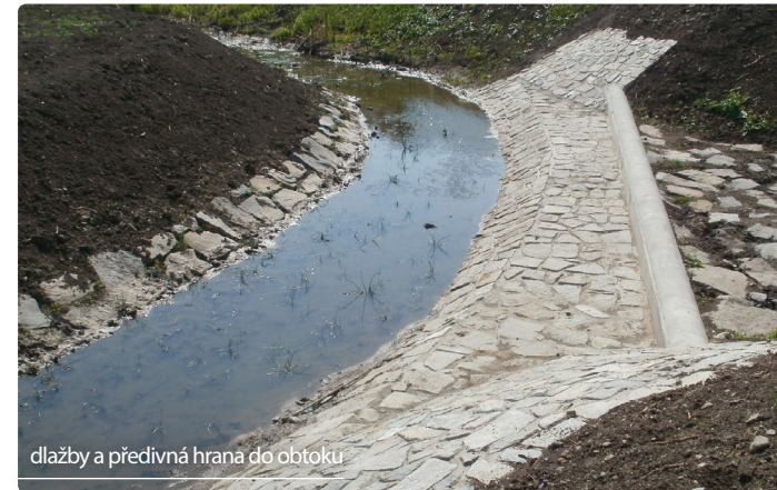
nový obtok vyústění ze zatrubnění
