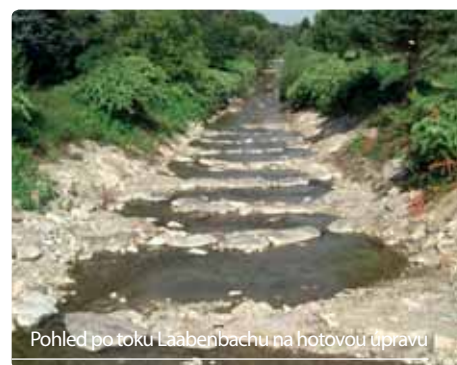
Úprava toku Laabenbach s lamelovým rybochodem
